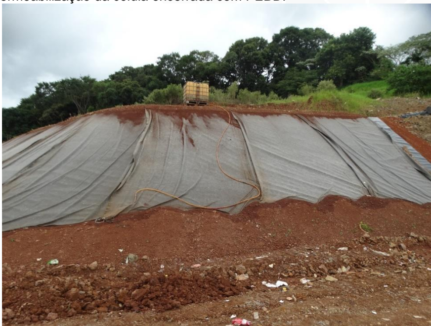
Figura 17: Impermeabilização da célula encerrada com PEBD.
