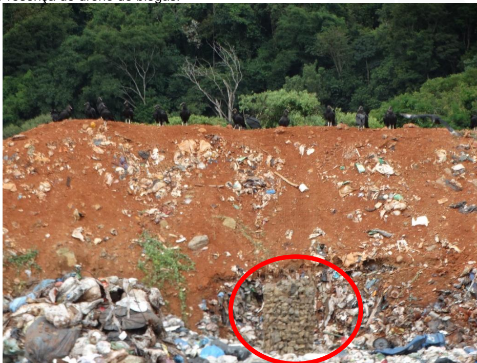
Figura 22: Presença de dreno de biogás.
