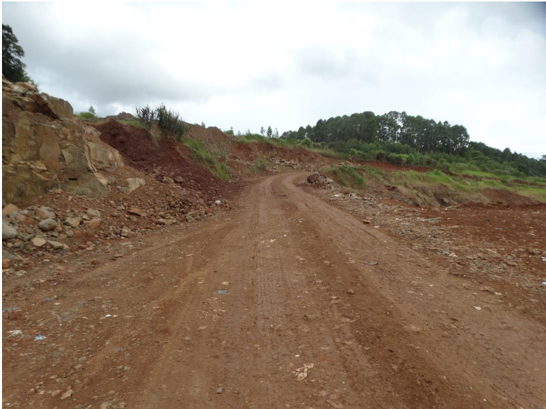
Figura 12: Estrada que dá acesso ao interior do Aterro.
