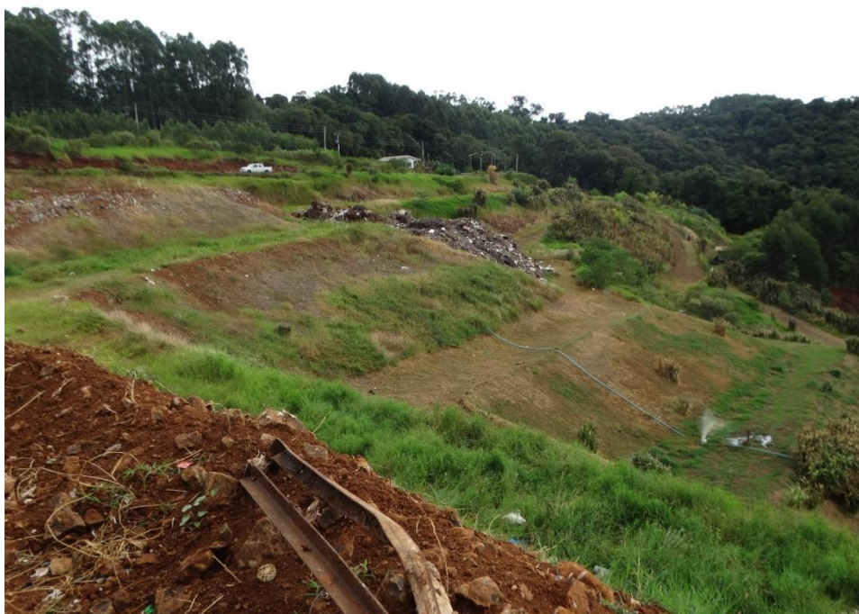
Figura 19: Ausência de sistema de drenagem.
