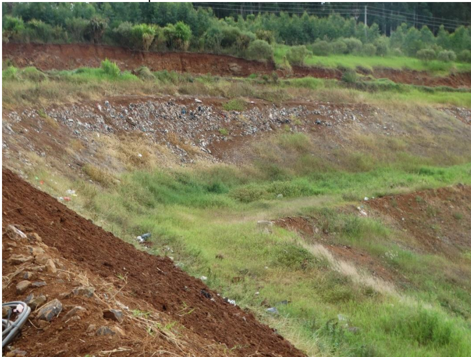
Figura 14: Cobertura final do aterro permitindo o contato do resíduo com o meio.
