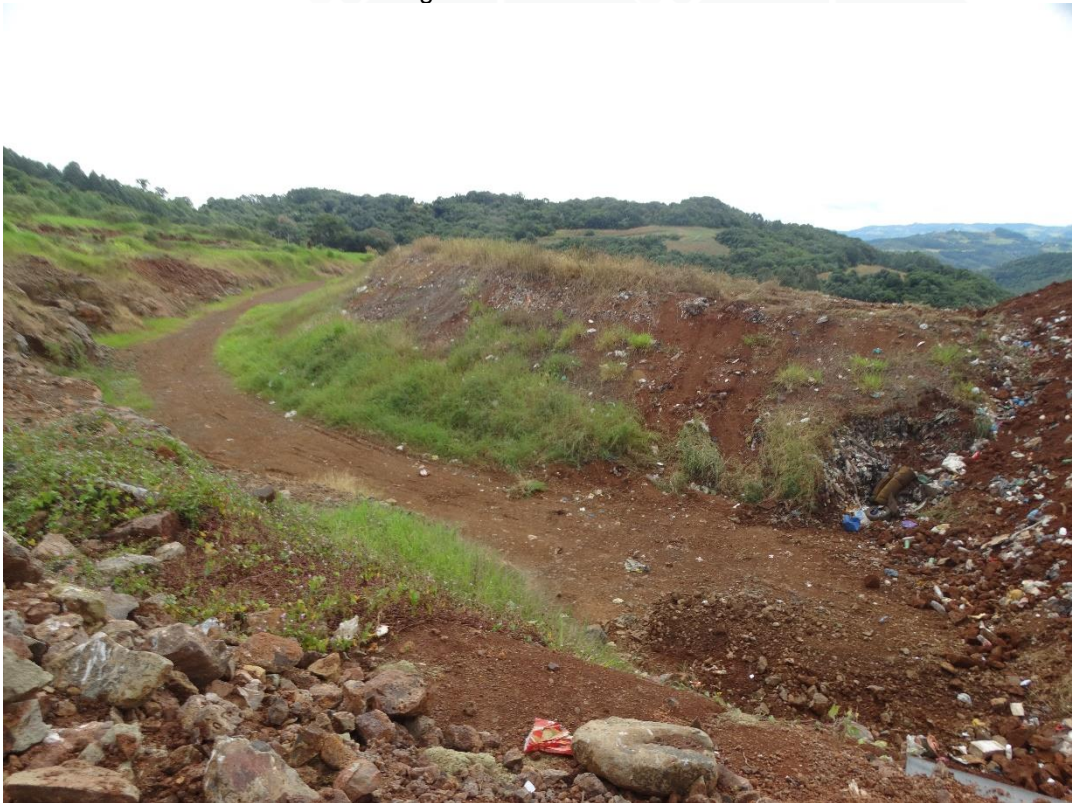
Figura 21: Ausência de sistema de drenagem.
