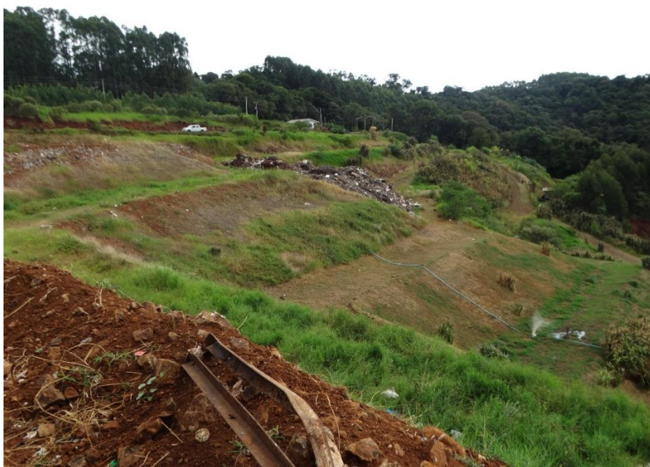
Figura 15: Cobertura das células encerradas com gramíneas e vegetação nativa e exótica formando a cortina vegetal
